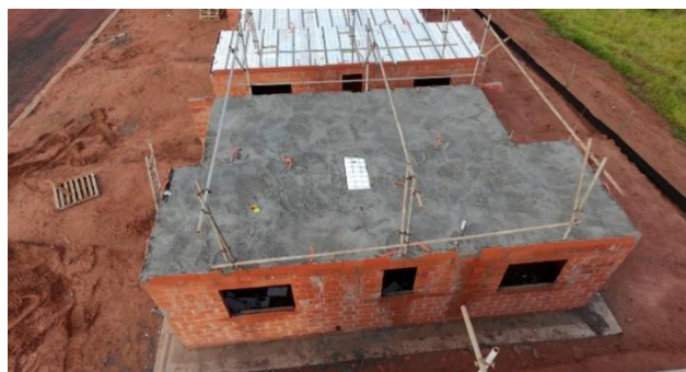
Figura 8 – Imagem aérea por drone com diagnóstico de falha de concretagem da laje da unidade.
