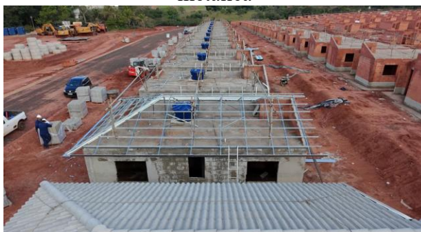
Figura 11 – Fiscalização do posicionamento dos caibros e itens relacionados a estrutura metálica
