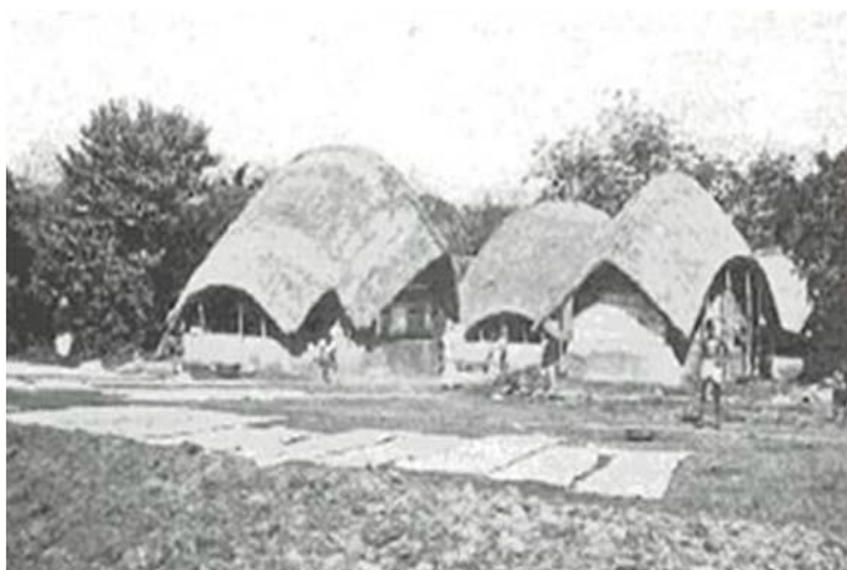
Figura 1. Bangalôs de arquitetura vernacular indiana. Fonte: Kramer, 2006, p.10
