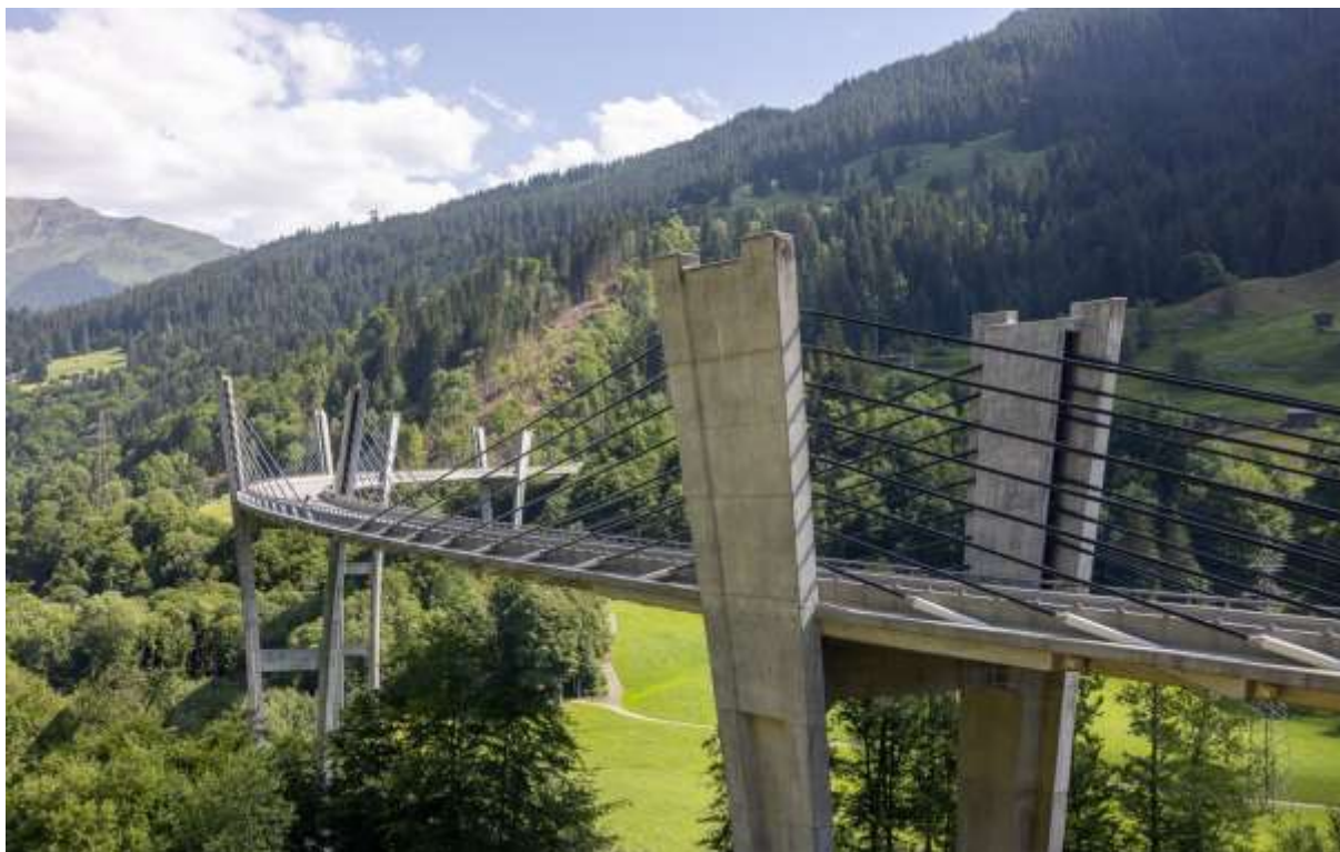
Figura 7 - Ponte Sunniberg, strallata tipo ventaglio. Fonte: Bridge Info (2026)
