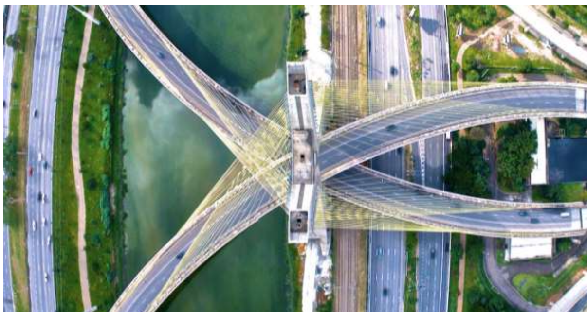
Figura 3. Ponte strallata Octavio Frias de Oliveira, San Paolo. Fonte: adattada da rhpissolatti
